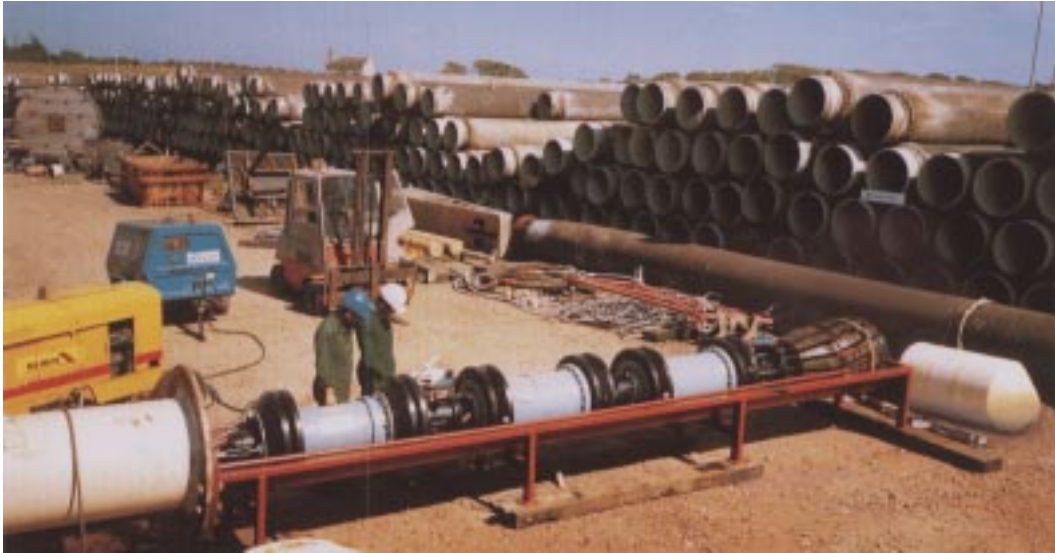
Abbildung 1.1: Ein Molch des UltraScan-Typs beim Einschleusen in eine Ölpipeline.
