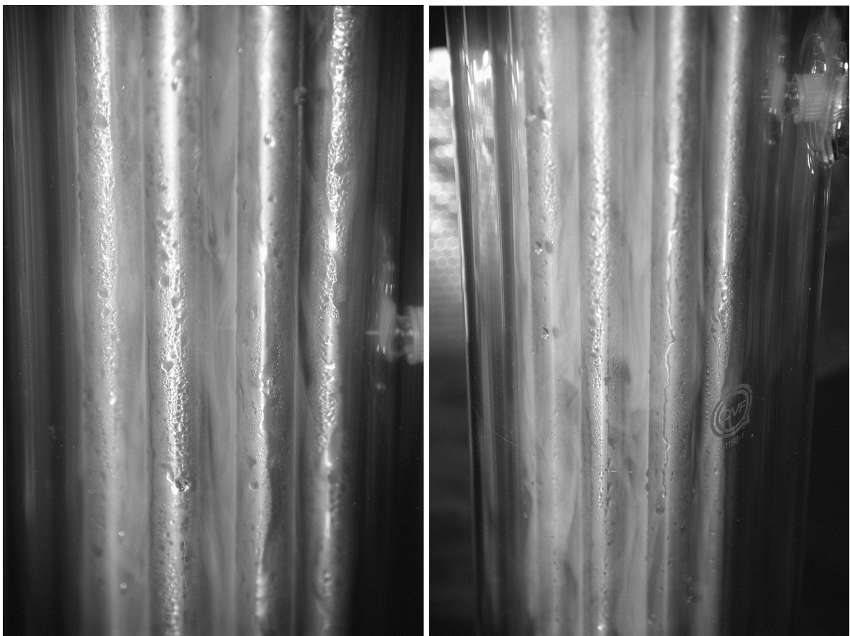
Bild 21: Nebel im oberen Drittel des Kondensators
