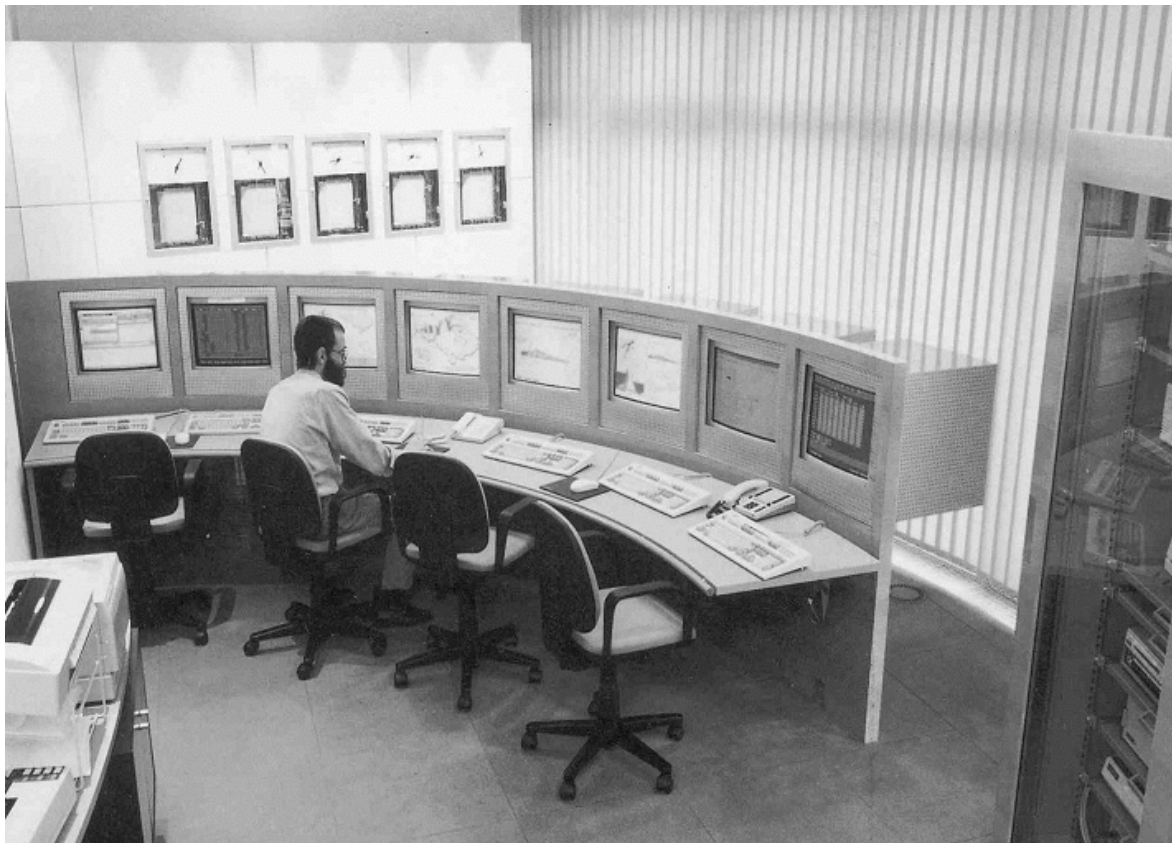
Abbildung 5-3: Leitzentrale des Ruhrverbands in Essen (Quelle: Ruhrverband)
