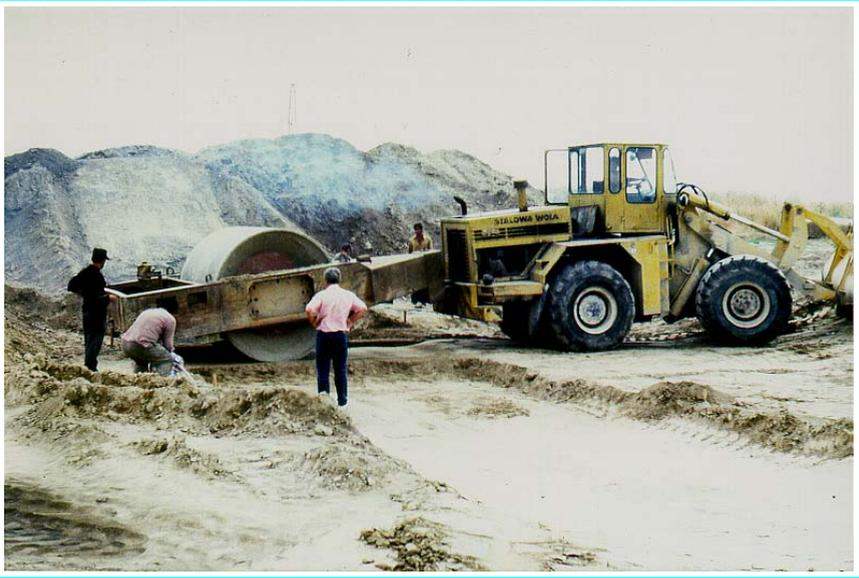
**Abb. 37:** Verdichtung der obersten CONSOLID - Schicht („d“)
