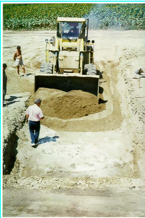
*Abb. 36: Radlader bei der gleichmäßigen Verteilung des behandelten Lößes auf dem Versuchsfeld in Cernavodă*
