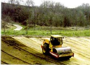
Verdichten des stabilisierten Materials mit «11t-Vibro-Glattwalze», 4-5 Walzdurchgänge.
