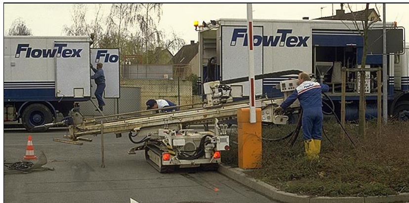
Abb. 49: Einrichtung des Bohrgerätes.
