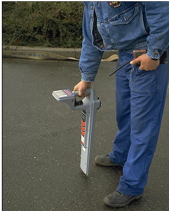
Abb. 50: Ortung der Spüllanze an der Geländeoberfläche (Ortungsgerät in der rechten Hand des Bohrmeisters; über Sprechfunk werden die Lage- und Tiefendaten der Spüllanze an das Bedienpersonal des Bohrgerätes weitergegeben).
