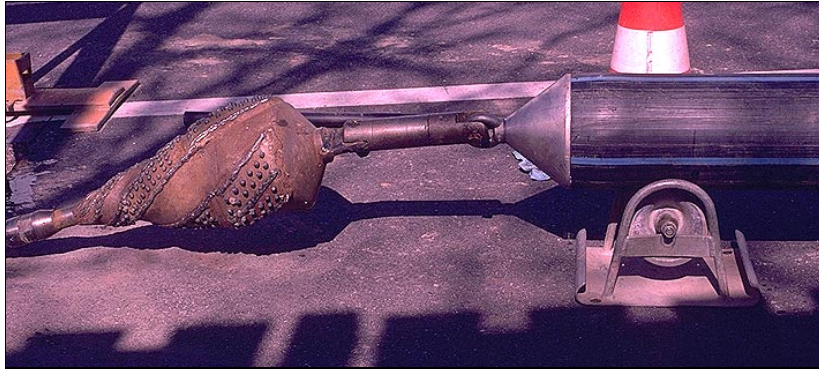
Abb. 51: Aufweitkopf mit unmittelbar folgendem Hüllrohr.
