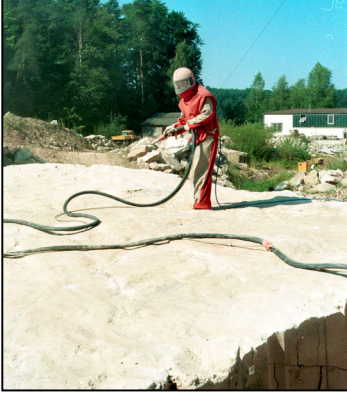
A-3.1: Sandstrahlen des gesägten Testfeldes
