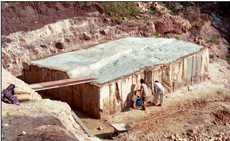
A-3.3: Harzauftrag auf Testfeldwände und -oberfläche
