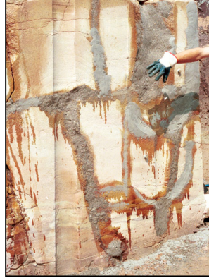
A-3.2: Verfugen der Klüfte auf Wandflächen
