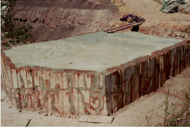
Abb. 3-11: Mit Trasszement verschlossene Kluftausbisse am Feldversuchsblock (Südost-Ansicht).
