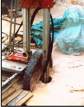
A-2.1: Tauchsägeeinheit Führungsbohrung
