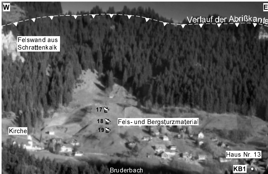
Abb. 4.1: Blick auf den Hang nördlich der Ebniter Kirche. Eingezeichnet ist der vermutete Verlauf der Abrißkante im Festgestein sowie die drei GPS-Punkte 17, 18 und 19 (Profil Mönchstor)
