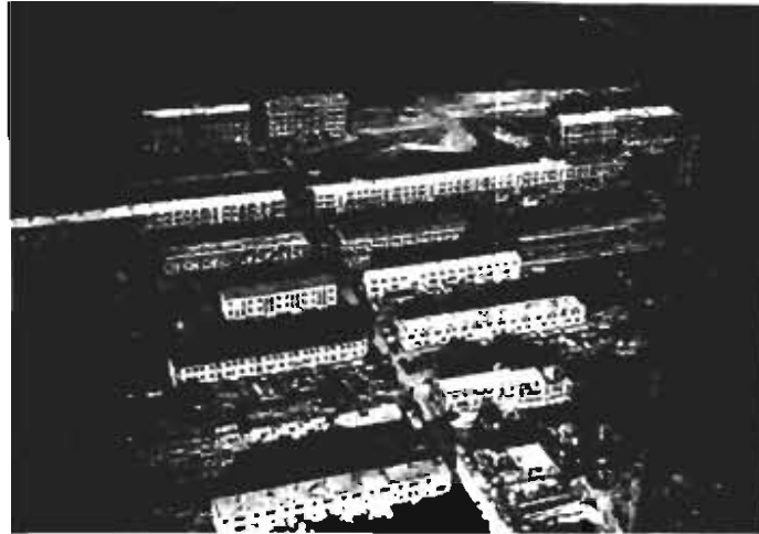
Abb.3.4: Siedlung Dammerstock, Luftaufnahme der Bauarbeiten (1929)
