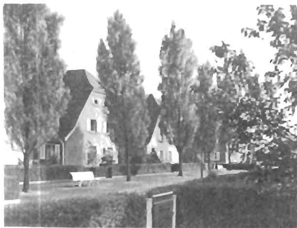
Abb 2.27: Straßenerweiterung am Heckenweg 1936.
