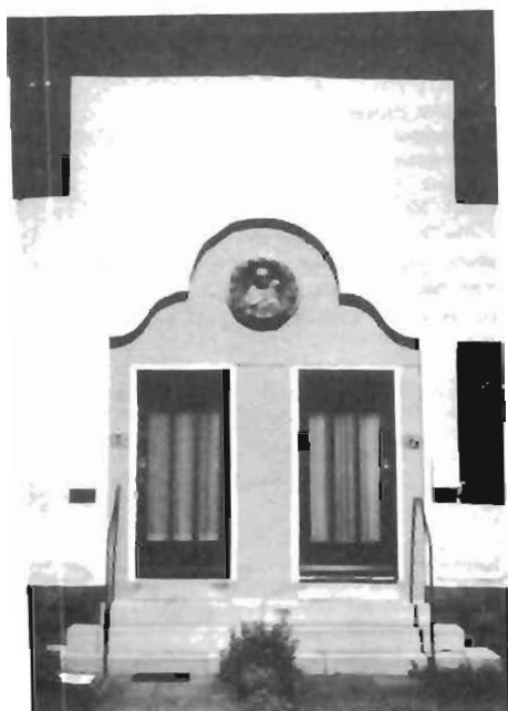
Abb. 2.24 Gekoppelte- Eingänge benachbarter Häuser
