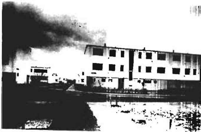
Abb. 3.54. Blick durch die südliche Ost-West-Straße (1929)
