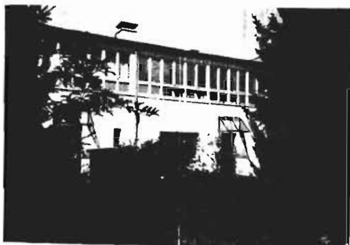
Abb. 3 58. Ausbau der Dachzone durch eine Verglasung der vormaligen Freisitze in der Reihenhauszeile von Meitz & Fischer
