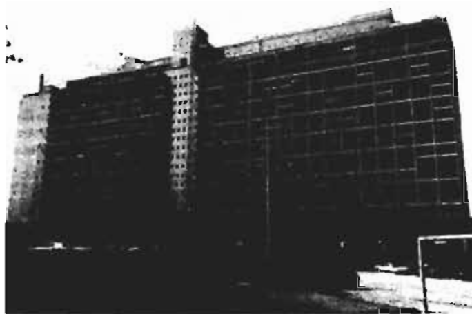
Abb. S.73: Ostansicht der Unité d'habitation in Firminy, 1959-67 (der Gebäudeteil rechts des Erschließungsturms steht seit 1983 leer)
