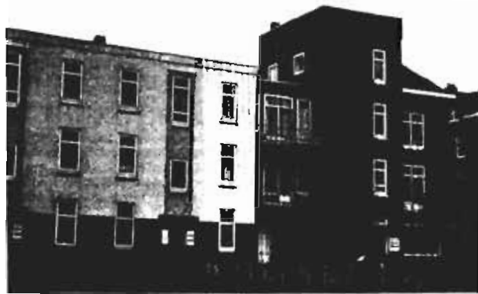
Abb.4.16 Ecklösung des Blocks VIII von J.J.P. Oud im Quarter Spangen (Zustand 1995, nach Fassadenerneuerung)
