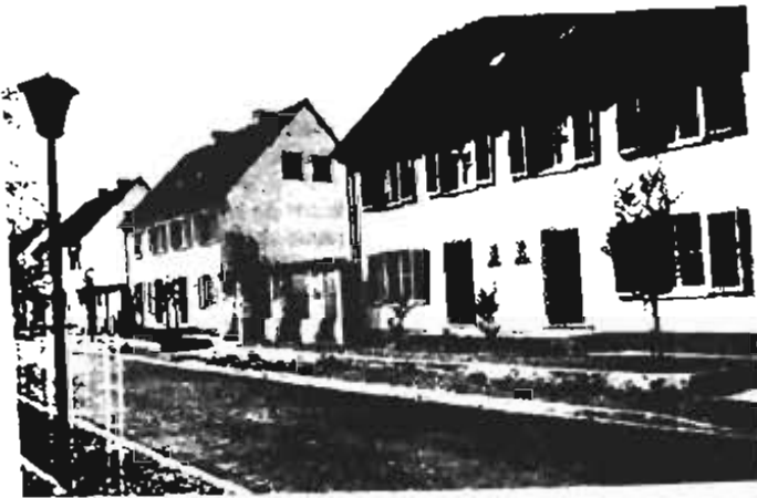
Abb. 3.18. Ergänzende Bebauung der 30er Jahre
