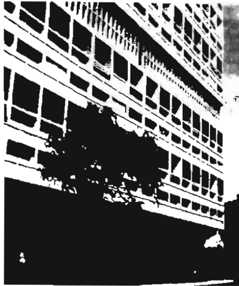
Abb. S. 50. Teilansicht der Westfront der Unite d'habitation
