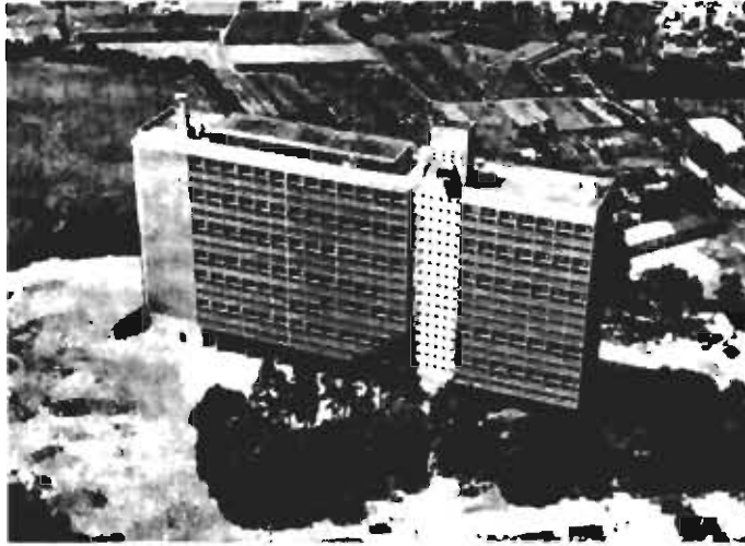
Abb. S.69: Luftaufnahme (von Osten) der Unité d'habitation in Nantes
