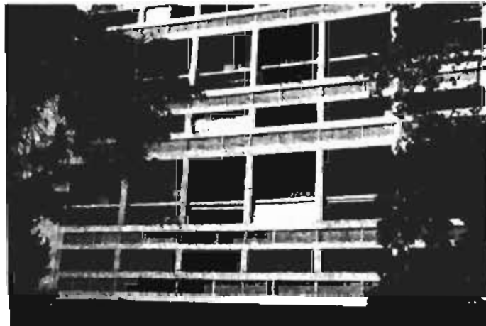
Abb. 5.55: Zusätzliche Sonnenschutzmaßnahmen auf der Westseite der Unité d'habitation in Marseille (1995)
