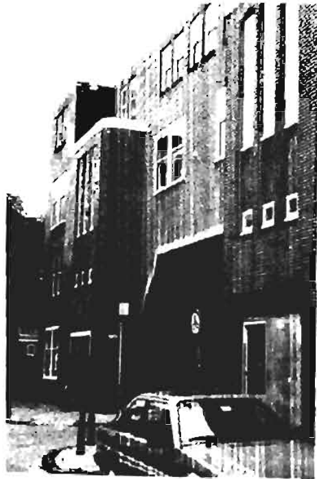
Abb. 4.48: Nordliche Tordurch- fahrt mit seitlichen Aufgängen zur Dach- straße (1995)
