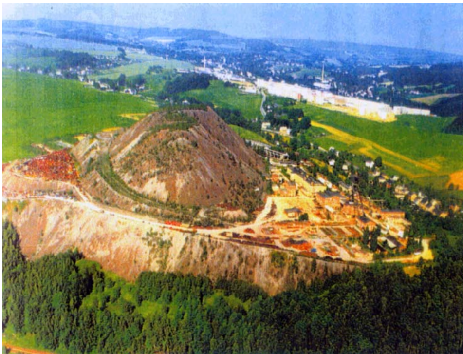
Abbildung 1: Abraumhalde aus dem Uranbergbau in Alberoda, Sachsen (Sanierungsbetrieb Aue). Vergesellschaftet mit den Uranerzen sind eisenhaltige Phyllitgesteine, die im wesentlichen aus Quarz, Muskovit, Feldspat und Chlorit bestehen.
